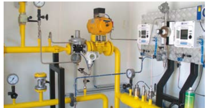
Übergabestation in das Erdgasnetz
